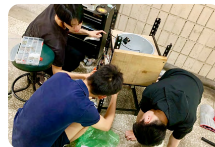
▲設備設計與組裝過程
