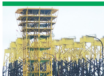
▲世紀鋼台北港離岸風電支撐結構檢視平台
