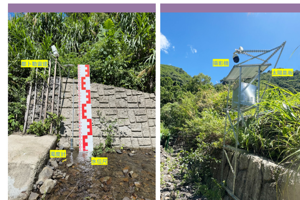
▲研究場址與監測設備。（左）水位尺、濁度感測器與都卜勒雷達。（右）設置於對面河岸之攝影機與太陽能板，用於持續監測。
